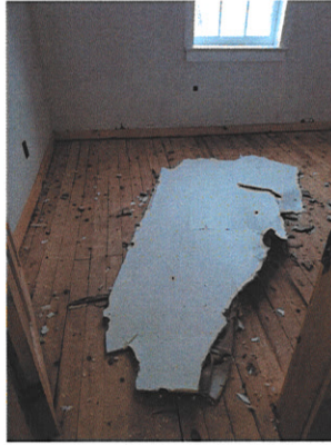
Collapsed Drywall
